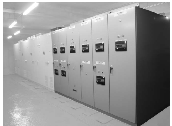
第14図 7.2kVハイブリッド絶縁開閉装置
