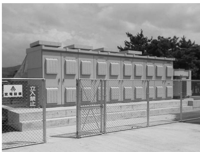
第25図 屋外盤収納形太陽光発電用PCS
