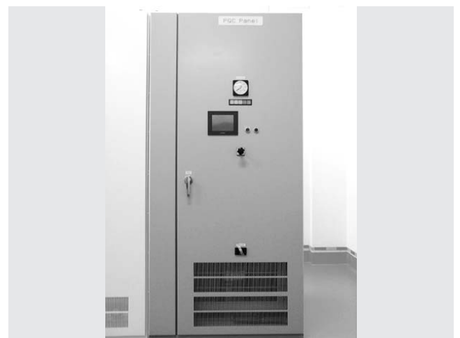
第22図 電力品質補償装置
