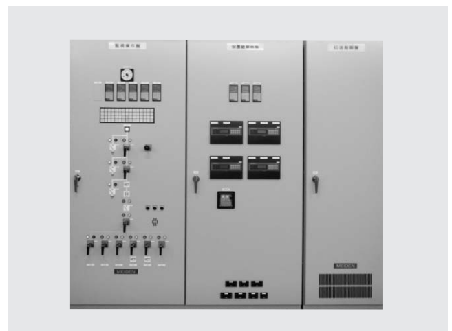
第6図 保護継電器システム
