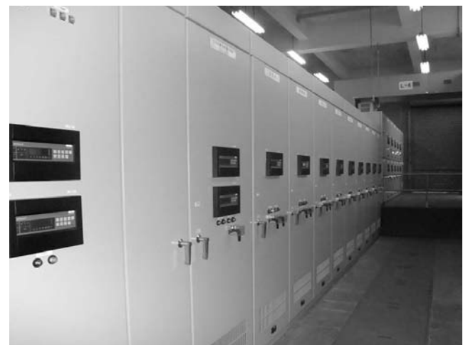
第5図 3kV高圧配電盤
