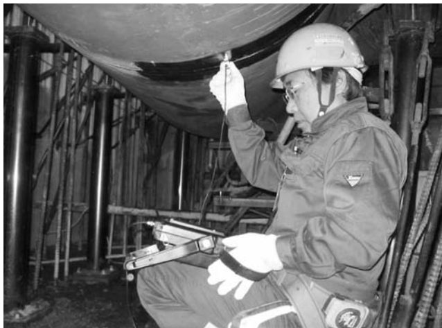
第18図 MT検査状況
