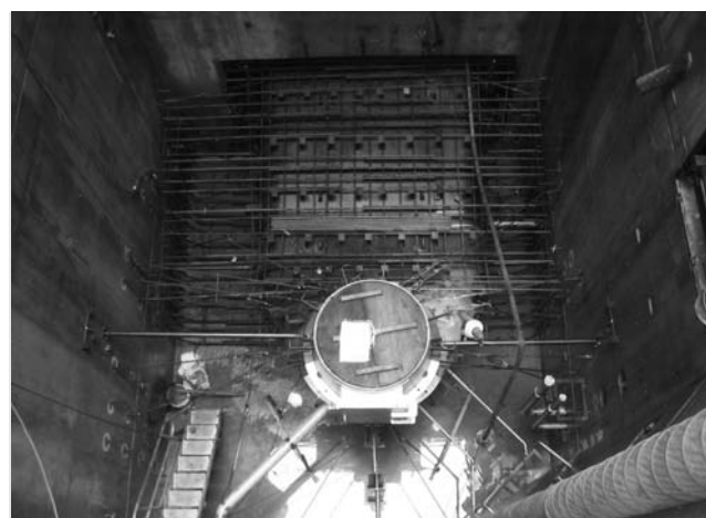
第7図 ドラフト管据え付け状況 ドラフト管の据え付け状況を示す。
