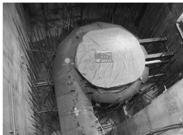
第8図 ケーシング据え付け状況 ドラフト管までコンクリート打設した後に施工する。
