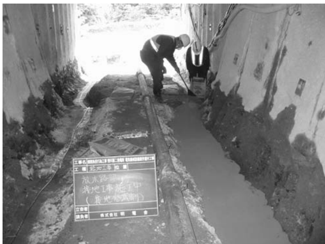
第4図 接地低減剤施工状況 メッシュアースの上に接地低減剤を散布している。
