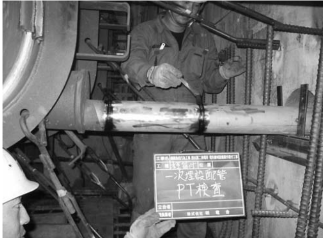
第17図 PT検査状況
