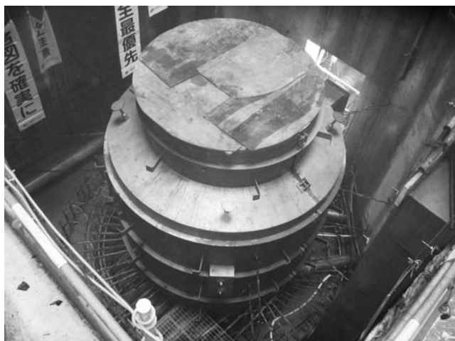
第9図 ピットライナ据え付け状況 ケーシングまでをコンクリート打設した後に施工する。
