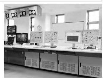
第13図 LCD監視制御装置
