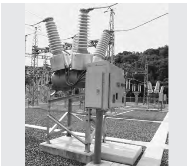
第9図 72kV SF 6 ガスレス形真空遮断器 九州新幹線に用いた真空遮断器の外観を示す。脱SF 6 ガス化を図っている。
