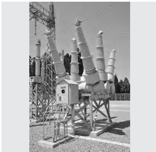
第4図 168kV真空遮断器
