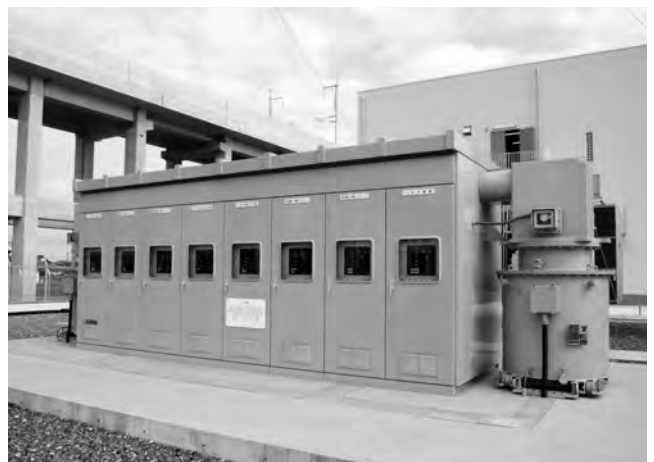
第11図 72kV屋外形C-GIS
