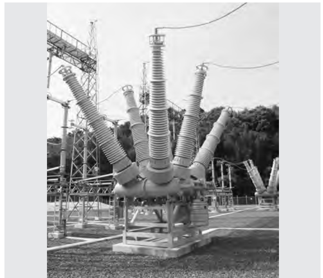
第5図 240kVガス遮断器
