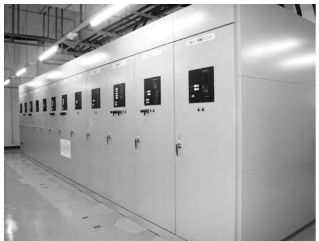
第12図 36kV屋内形C-GIS
