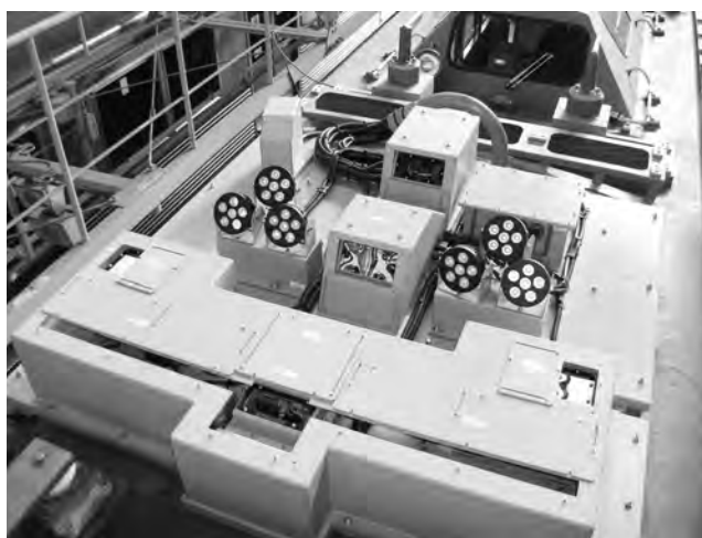
第4図 屋根上機器カバー
