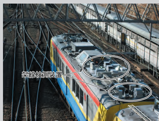
当社架線検測装置を取り付けた電気検測車
