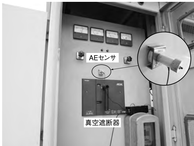
第3図 AEセンサの取り付け例
