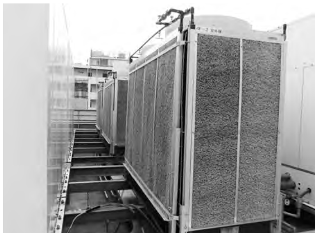
第4図 間接散水冷却装置設置例 屋上に設置されたシステムを示す。
