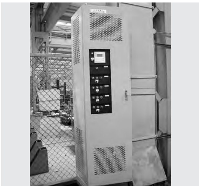
第2図 低圧自動力率改善装置設置例
