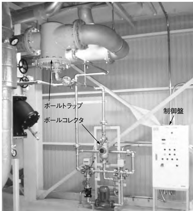
第3図 ボール式熱交換器自動洗浄装置全景 1トラップシングルシステムの全景を示す。ボールトラップ・ボールコレクタ・バルブユニット・制御盤で構成する。
