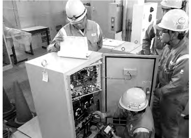
第7図 電力変換装置教育 研修用10kW太陽光発電設備を使用した教育を実施する。
