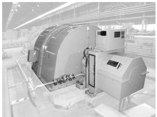
第6図 大形巻線形誘導電動機
