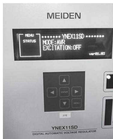
第1図 デジタル式静止励磁制御装置（ヒューマンインタフェース部）
