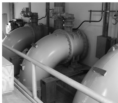
第20図 立軸水中タービン発電機
