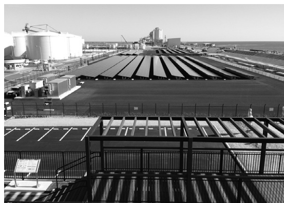
第24図 原町太陽光発電所全景
