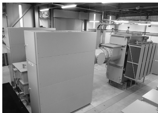
第10図 縮小C-GISと特別高圧変圧器
