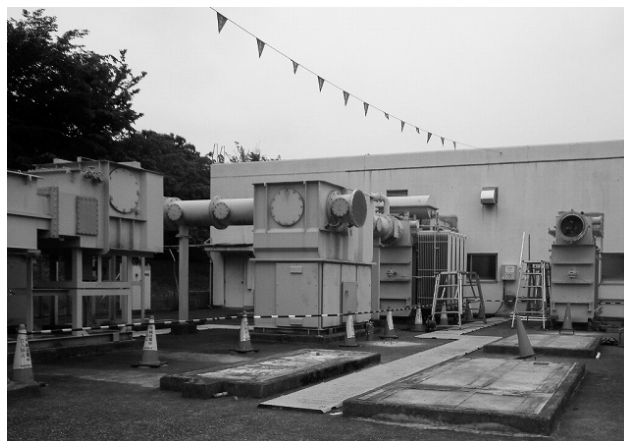
第 3 図 更新工事の近接作業
