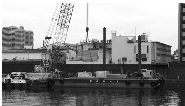
第16図 台船による発電機の搬入状況
