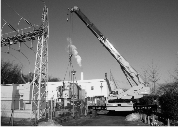
第4図 搬出入時の揚重機作業
