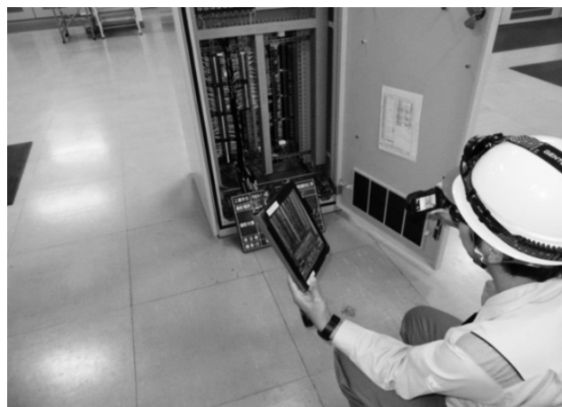
(b) 施工チェック状況
