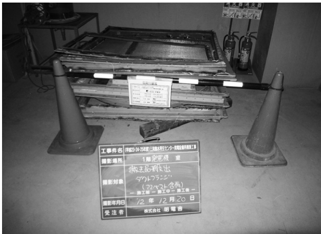
第10図 空調ダクトのフランジパッキン処分
