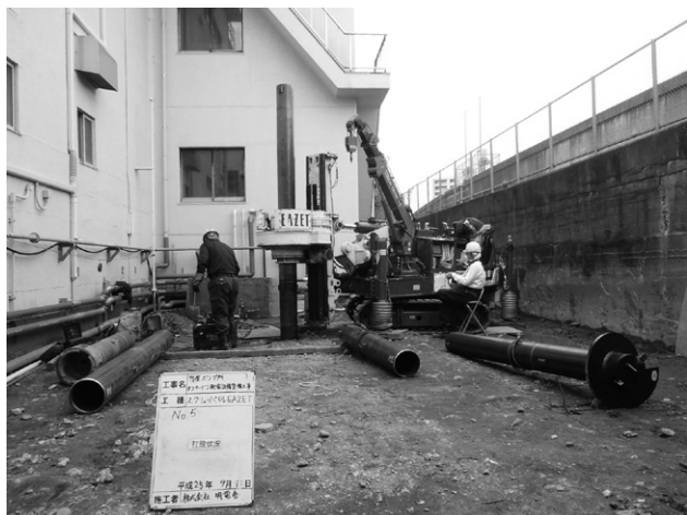
第14図 発電機基礎杭工事
