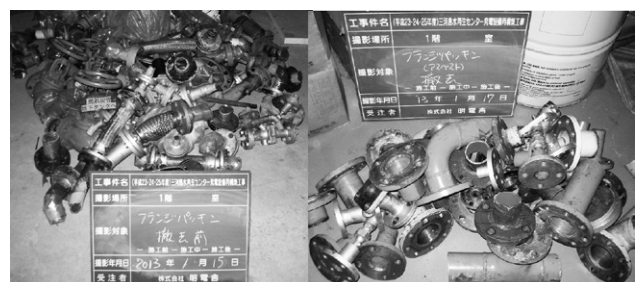
第9図 燃料配管フランジパッキンのアスベスト除去
