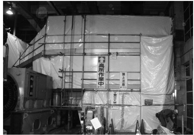
第7図 エンジンのアスベスト除去状況
