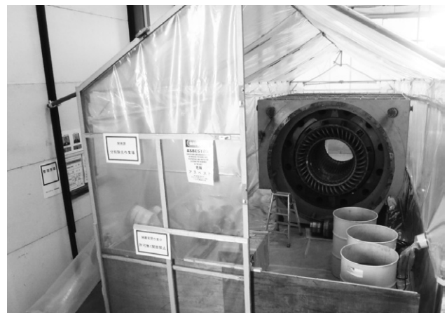
第8図 発電機本体のアスベスト除去作業
