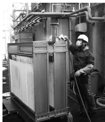
第7図 膜ユニットの洗浄
