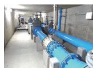
配水池（配水管廊）
