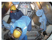
風車内部の作業風景
