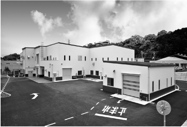
第 6 図 汚泥再生処理センター
