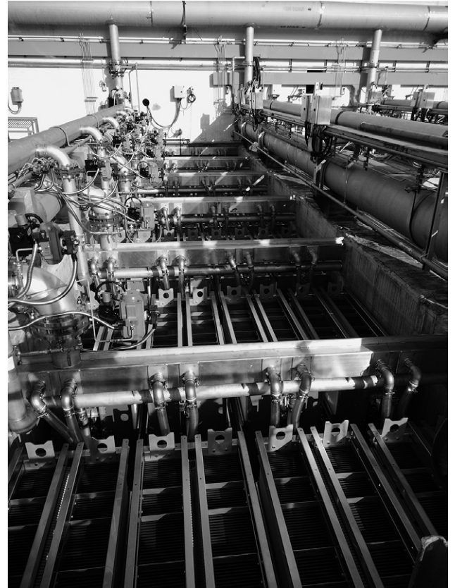
第 7 図 チェスナッツアベニュー浄水場 セラミック平膜ろ過設備
