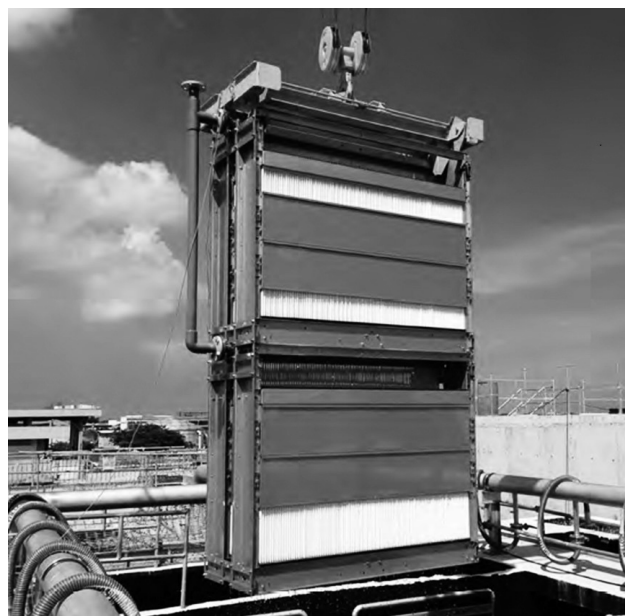
第3図 工業団地集合排水処理設備 セラミック平膜ユニット
