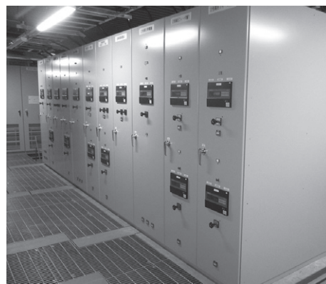
第3図 高圧盤 (H-AIS)
