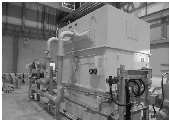
第6図 4極蒸気タービン発電機
