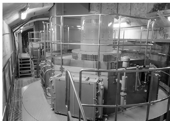
第4図 立軸三相同期発電機
