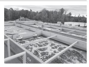
第6図 セラミック平膜を用いた排水処理設備
