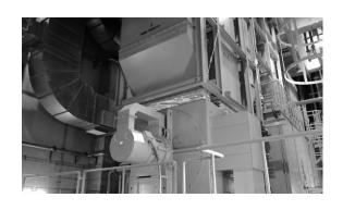
第3図 非常用発電装置 (6.3kV 23MW)
