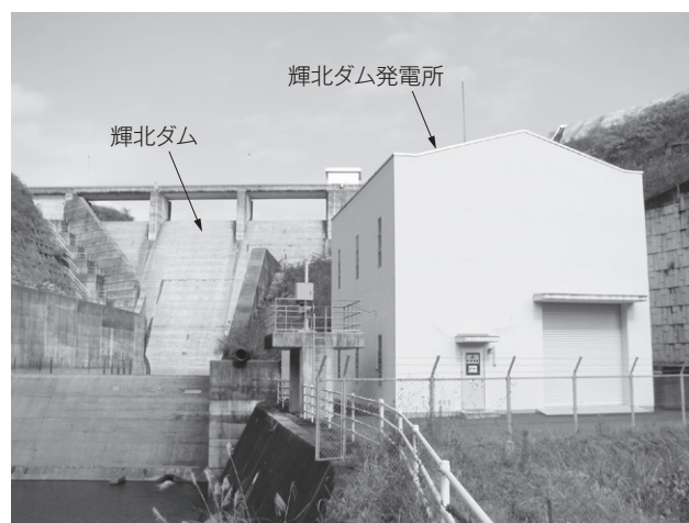
第1図 輝北ダム及び輝北ダム発電所
