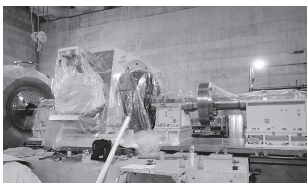
第9図 回転子の挿入状況
