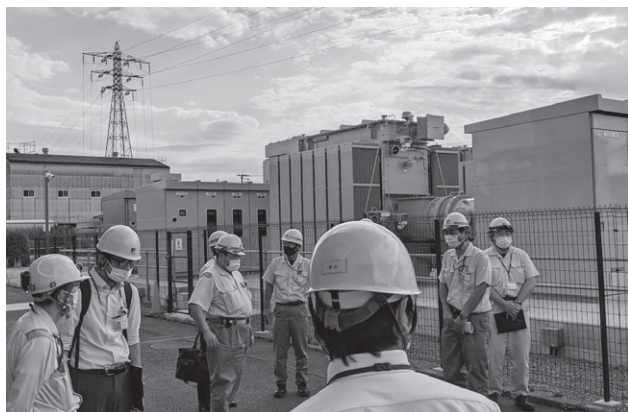
第6図 特高変電所での見学会の様子
