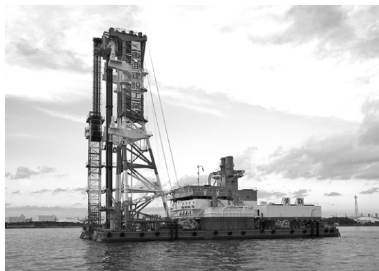
第1図 深層混合処理船「黄鶴」
