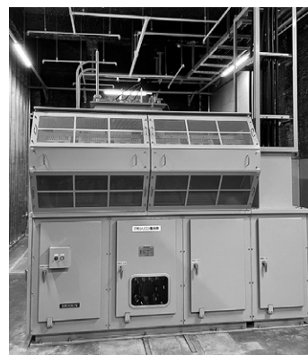
第3図 ヒートパイプ式シリコン整流器
