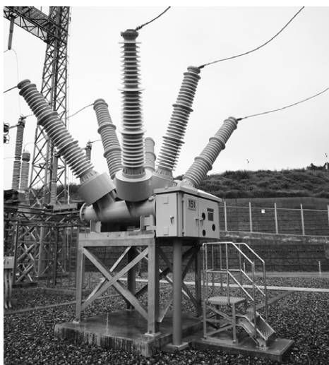
Fig. 3 168kV GCB
