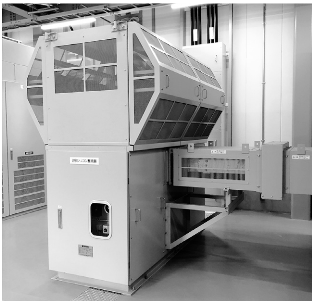
Fig. 5 Rectifier Unit
