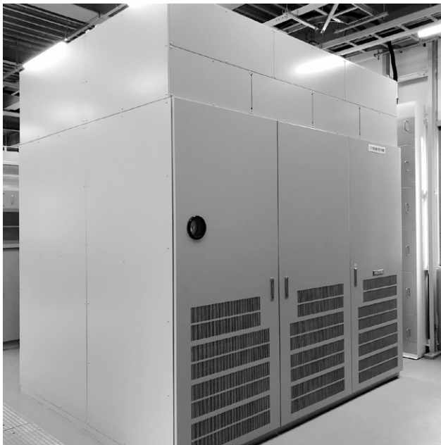
Fig. 4 Rectifier Transformer
