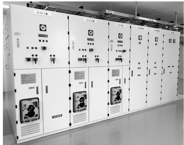
Fig. 6 DC Switchgears
