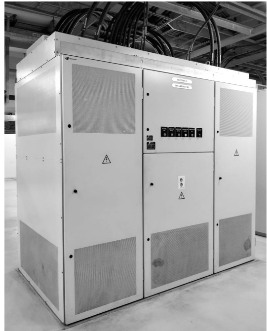
Fig. 8 Rectifier Unit
