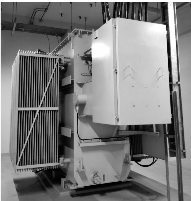
Fig. 7 Rectifier Transformer
