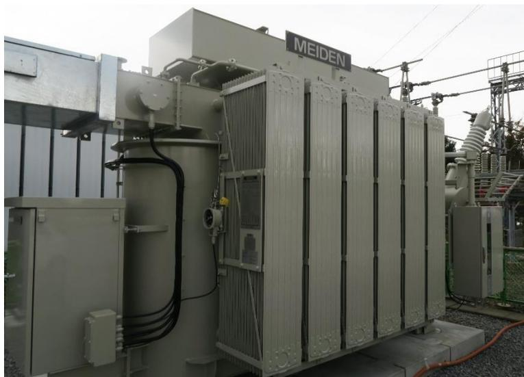
本製品は、絶縁油に植物由来のパームヤシ脂肪酸エステル（以下、パームヤシ油）を使用したエステル油入配電用変圧器で油入全装輸送を可能としました。東京電力 PG ではパームヤシ油のほか、天然エステル（大豆油・菜種油）を使用した配電用変圧器も採用いただく事が決定しており、今後も順次お納めする予定です。
